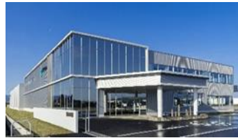
立山第3工場 富山県中新川郡立山町利田161
