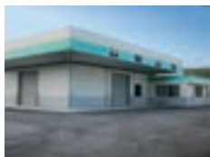
アルファフレーム九州 (福岡県大牟田市)
