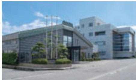
富山本社/流杉工場
