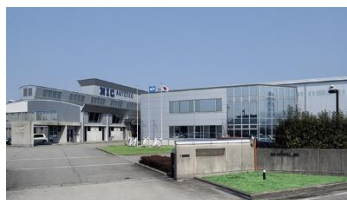
立山第1工場/開発センター
