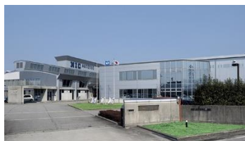
立山第1工場/開発センター
