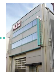
アルファフレーム関西
