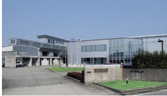
立山第1工場/開発センター
